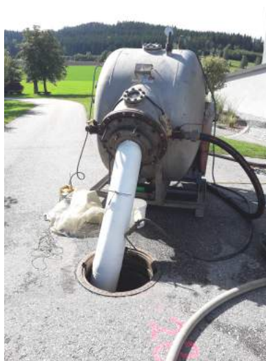
Sanierung der Kanalstränge
