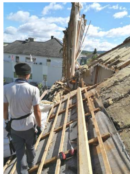
Entfernung der Dachstuhlkonstruktion durch die Firma Wegrath, Bauhofmitarbeiter und freiwillige Helfer.
